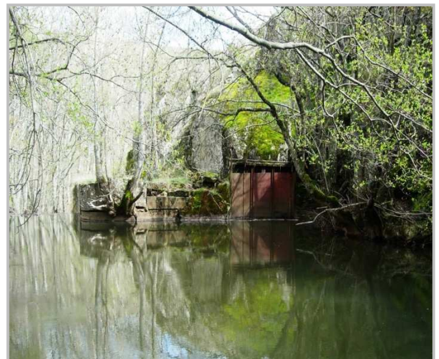
Compuerta de la presa La Constante
