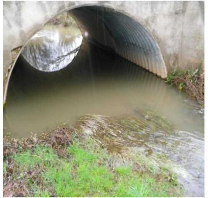
Puente de la carretera que une Los Condemios. Abril 2010
