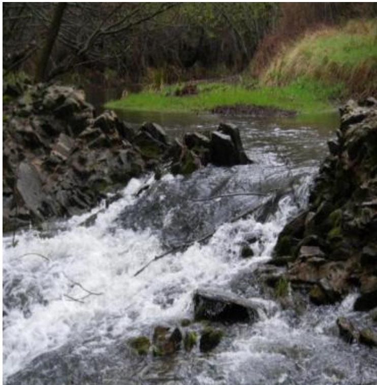
Dique derruido y comienzo del tramo en H30 X501426 Y4559051
