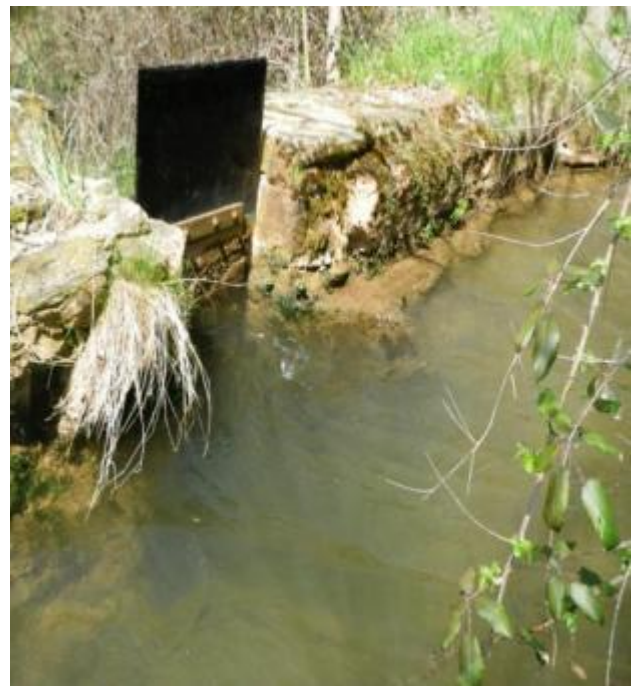
Compuerta que regula el caudal del río
