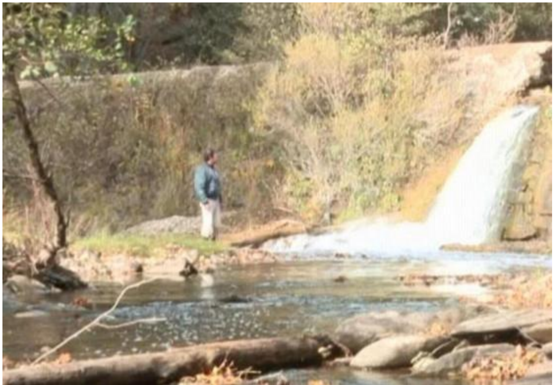
Presa de Hiendelaencina. Noviembre 2009
